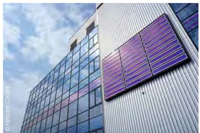
BIPV-Fassade bei ENGIE Fabricom, Antwerpen
