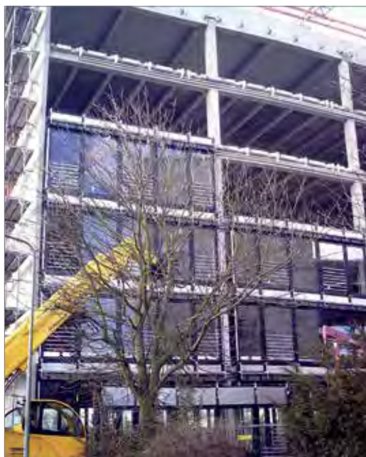
Der Einbau von Fassadenelementen in eine Skelettkonstruktion
