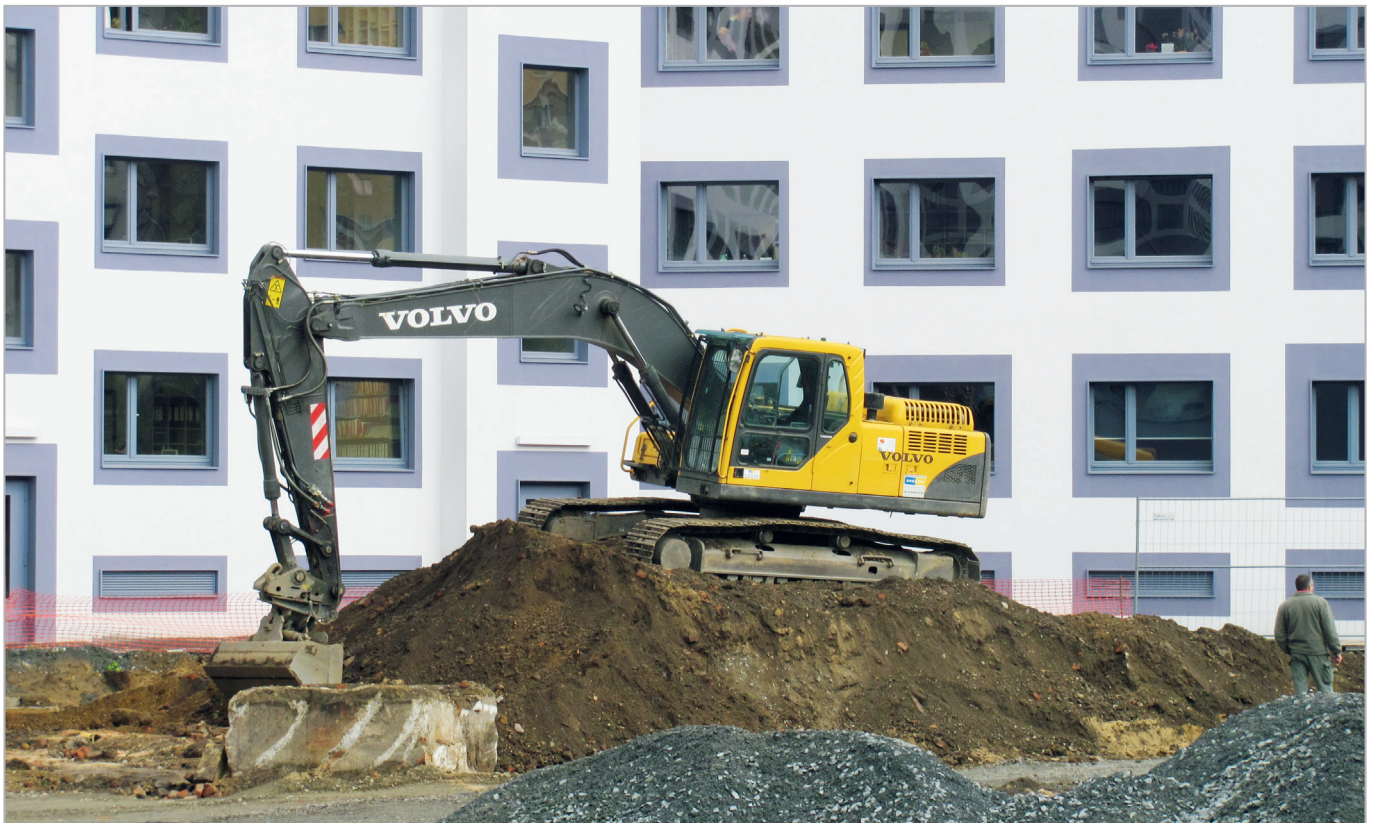
Abb. 1: Energetische Sanierung des Finanzamts Dresden-Nord und -Süd: Mit reichlich Dämmung wurde der DDR-Plattenbau zum Passivhaus umgebaut. Im Innenhof werden noch bergeweise mineralische Baustoffe bewegt. Baustoffe, Energie und Flächen werden durch die Bauwirtschaft in gebaute Umwelt, behagliche Wohngebäude, Büros, Produktionsstätten und Infrastruktur verwandelt.
