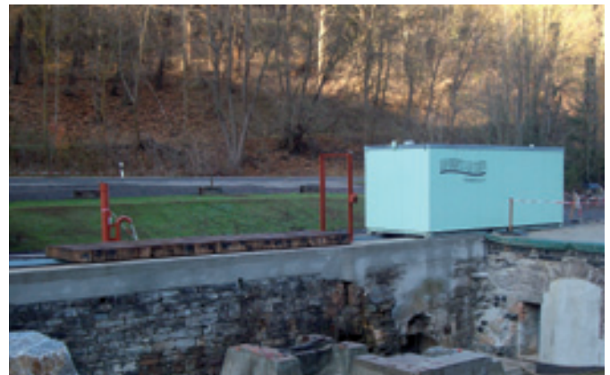
Der ENERTAINER, eine im Netzwerk entwickelte neuartige Containerwasserkraftanlage (Quelle: Netzwerk Fluss-Strom)
