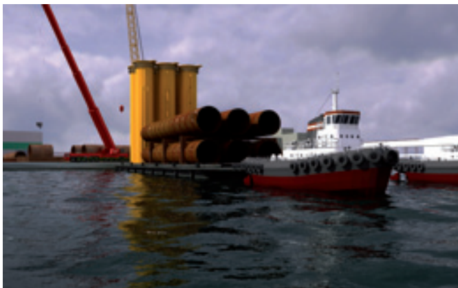
Lagerung, Verladung und Transport von Stahlrohren der Fa. EEW Special Pipe Constructions GmbH zum Bau von Offshore-Windkraftanlagen (Quelle: werkfilm.de)
